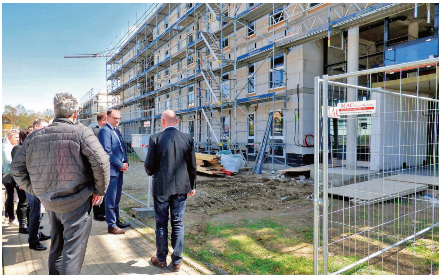
Ab Herbst gibt es für Senioren in Seesen noch mehr Platz. In der vergangenen Woche wurde bereits Richtfest in der Hochstraße gefeiert, der Rohbau steht.
